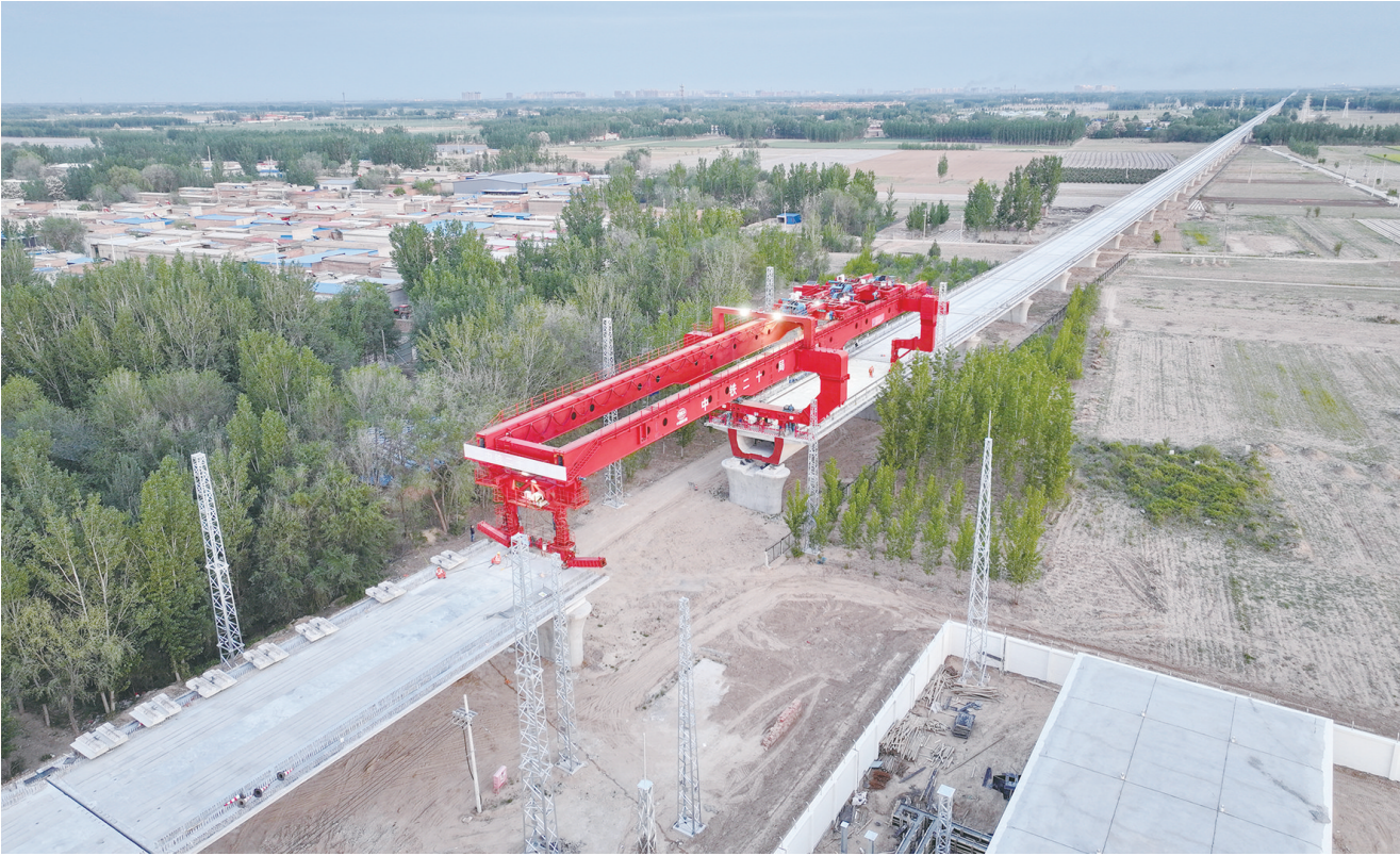
4月27日，由中铁二十局集团等单位承建的雄商高铁枣清特大桥完成箱梁架设，雄商高铁河北段架梁施工全部完成。雄商高铁是我国高速铁路网“八纵八横”之京港(台)通道的重要组成部分，正线全长552公里，设计时速350公里。 新华社记者 牟宇 摄
