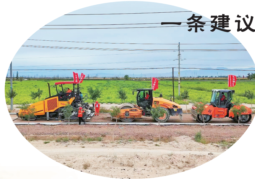
“天小路”施工现场。记者 屈冰 摄
