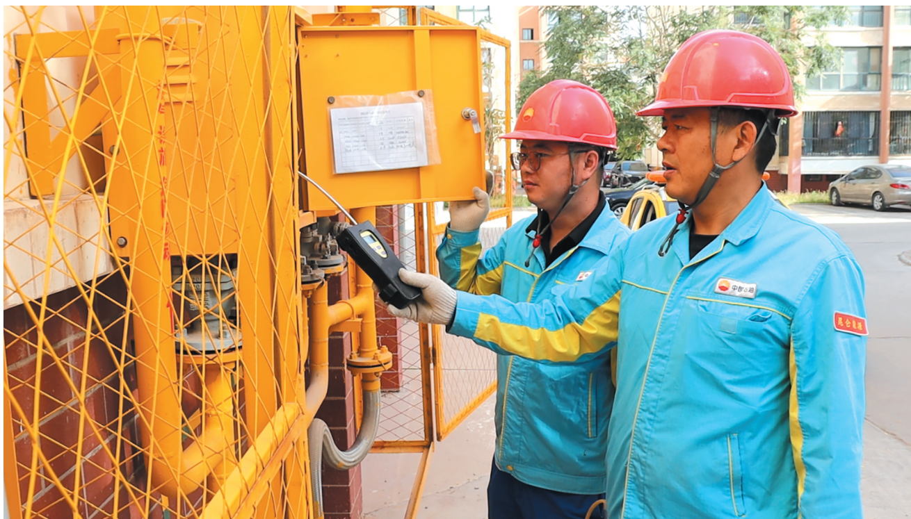
为积极应对即将到来的冬季用气高峰,9月起,金昌昆仑燃气公司主动出击,提前精心谋划冬季保供举措。图为工作人员正在排查安全隐患,确保民生用气安全稳定。记者 何瑞锦 摄
