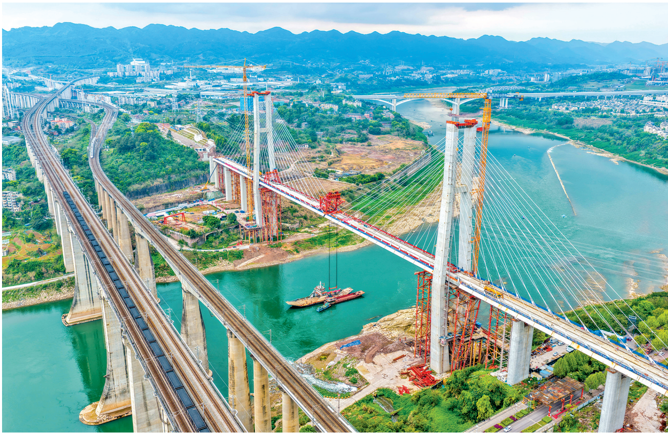
3月31日，由中铁大桥局承建的成渝中线高铁井口嘉陵江特大桥顺利合龙，标志着成渝中线高铁全线桥梁全部合龙，为按期通车奠定了坚实基础。 成渝中线高铁是我国“八纵八横”高铁网沿江通道的重要组成部分，正线全长292公里。 图为成渝中线高铁井口嘉陵江特大桥建设现场(无人机照片)。 新华社记者 唐奕 摄
