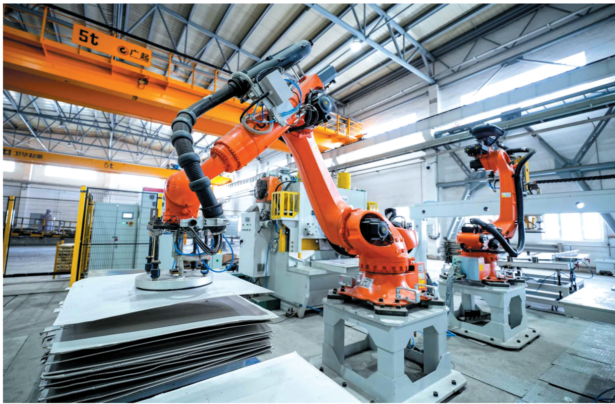
金川集团镍钴股份有限公司镍冶炼厂智能化成品库。 金川集团新闻中心供图
