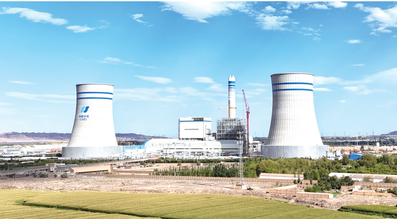
近日，华电金昌2×1000兆瓦调峰煤电项目迎来关键建设节点，项目从基建安装阶段正式转入调试投产阶段。作为保障“陇电入浙”特高压直流外送通道稳定运行的关键调峰支撑电源，这一节点的达成，为项目按期投产发电奠定了坚实基础。 记者 张宏斌 摄
